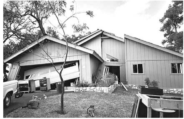
Figura 5 – Terremoto de San Simeon, Dic. 22, 2003 Esta casa se deslizó dos pies hacia fuera de sus cimientos debido a un inadecuado anclaje de las paredes a sus bases.
