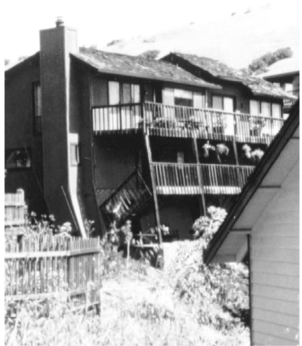
Figura 22 – Esta casa en un talud, fue construida sobre un muro sin refuerzo, el cuál se cayó.
