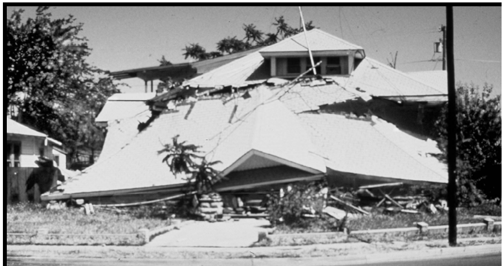
Daños por temblores adicionales
