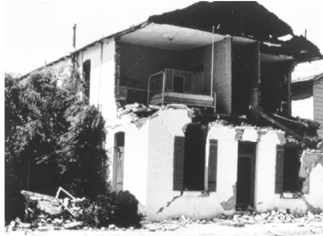
Figura 25 – Las paredes de ladrillo de este edificio, recubiertas de aplanado de mezcla, se derrumbaron durante un terremoto.
