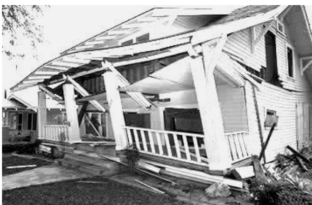
Figura 3 – Terremoto de Northridge, Ene. 17, 1994. Daño de residencia uni-familiar a causa de fallas en múltiples elementos.
